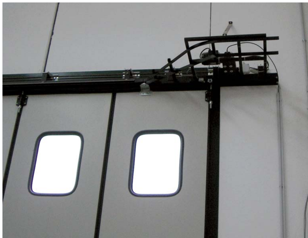
Dettaglio guida superiore motorizzata - Vista interna
