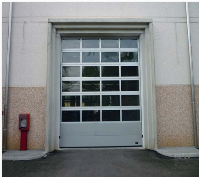
Portone sezionale versione PANORAMA, con pannelli in alluminio e tamponamento in metacrilato
