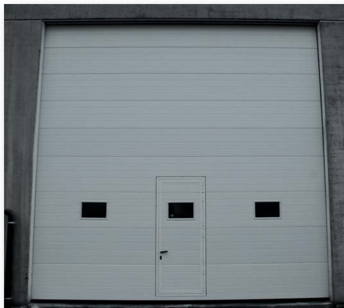
Portone sezionale con porta pedonale inserita ed oblò rettangolari
